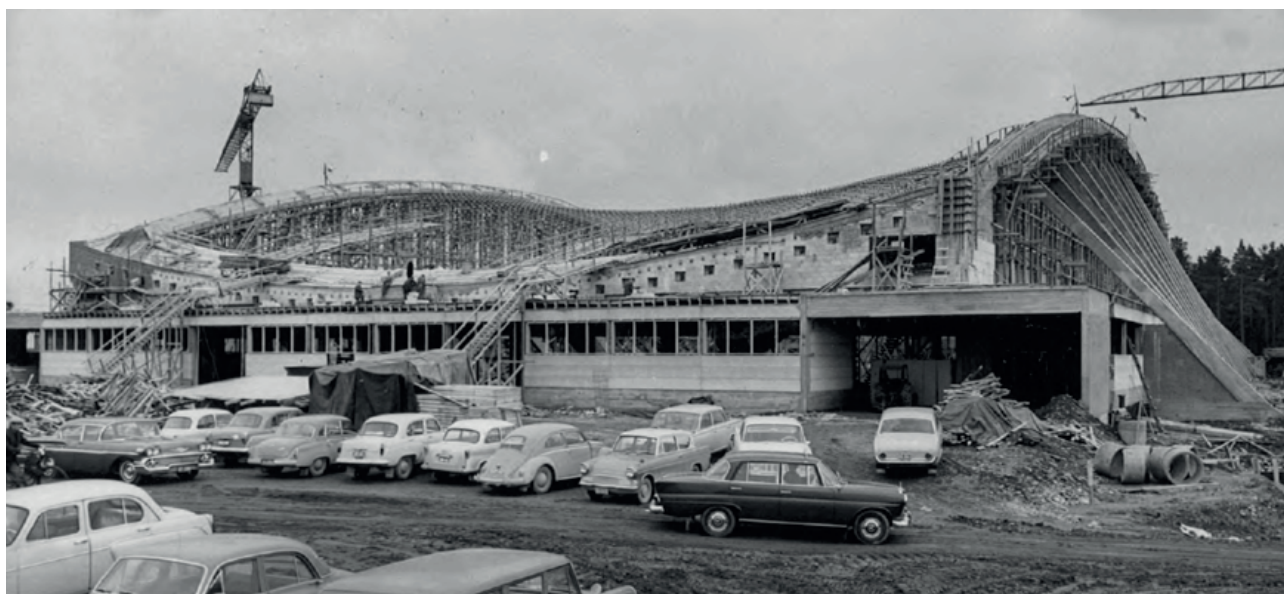
3. Haka 1 -halli rakenteilla syksyllä 1964. Kuva: Tampere-Seuran kuva-arkisto / Lintinen
